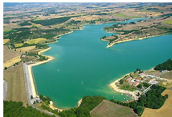
Barrage de la Ganglise
